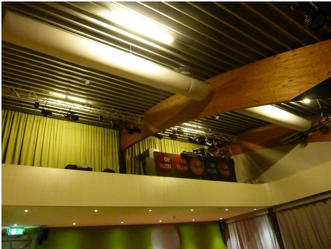
Foto 3 Grid boven het balkon over de volle breedte van het speelvlak en de regieruimte
